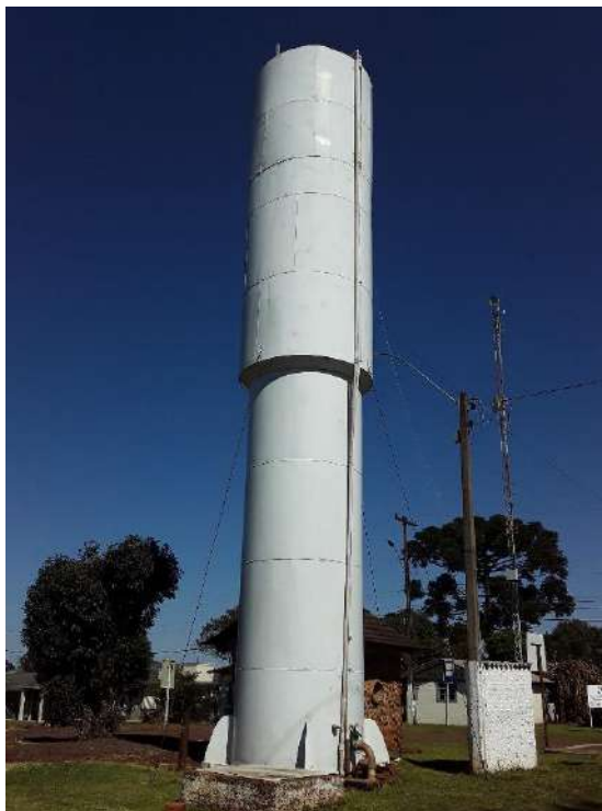
Figura 52 – Reservatório de água pertencente à Associação Comunitária dos Consumidores de Água da Cidade de Almirante Tamandaré do Sul.
