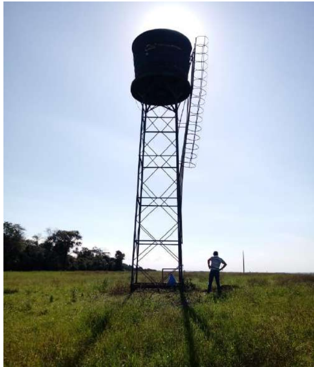
Figura 63 – Reservatório do SAA Linha Barra.
