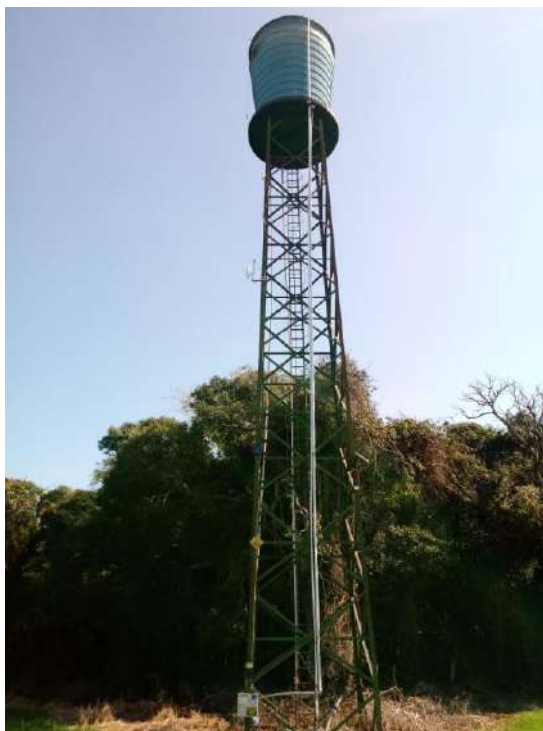
Figura 53 – Reservatório do SAA Linha Dupla.
