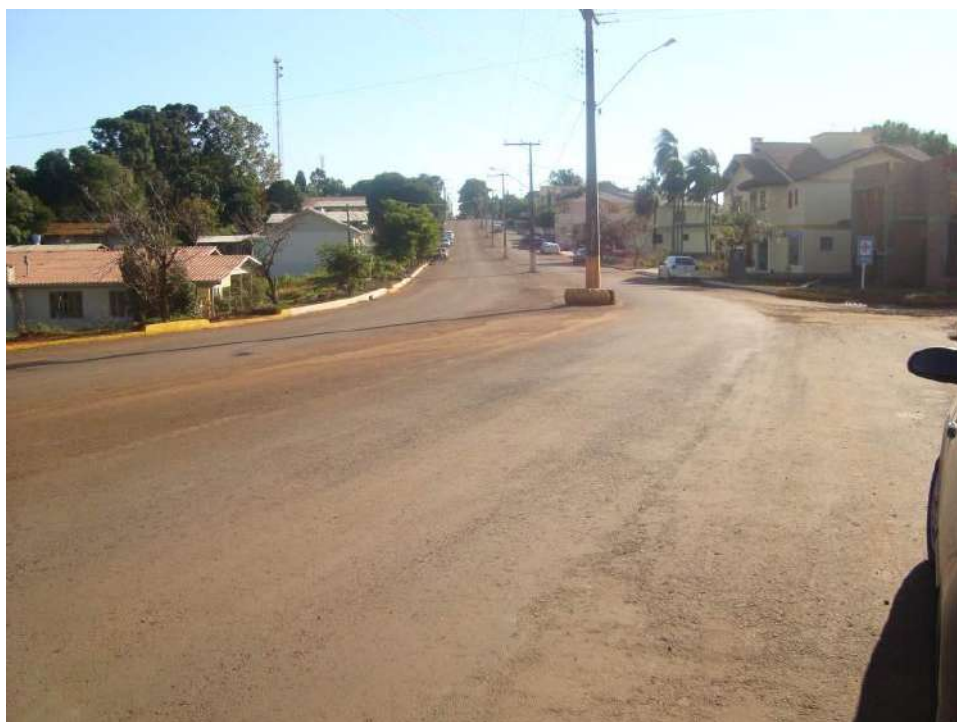
Figura 88 – Avenida principal do município contendo pavimentação asfáltica e sistema de drenagem.
