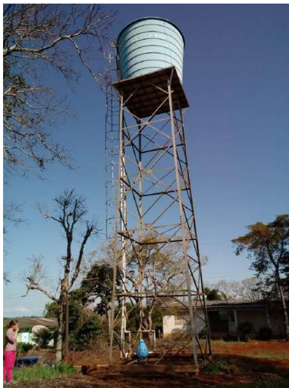
Figura 66 – Reservatório do SAA Vila Seca.
