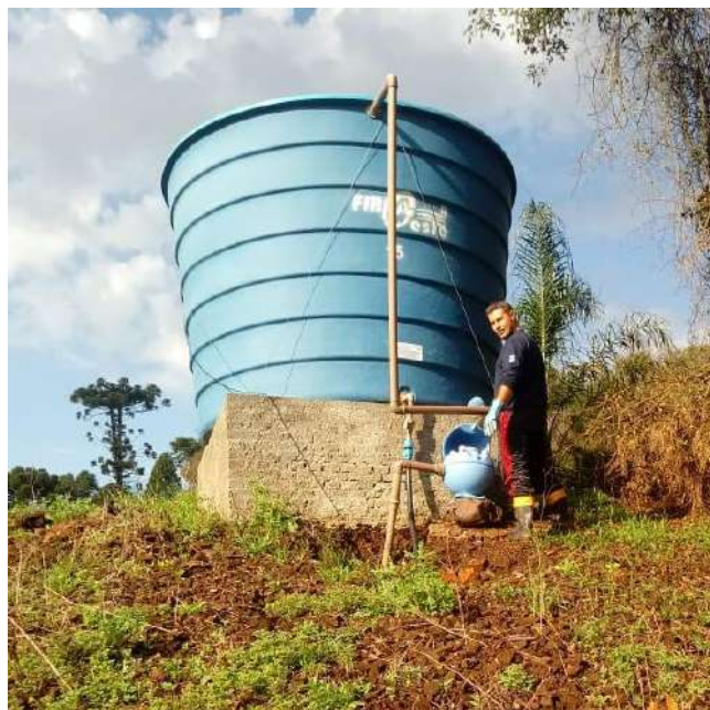
Figura 62 – Reservatório do SAA Linha Guamirim II.
