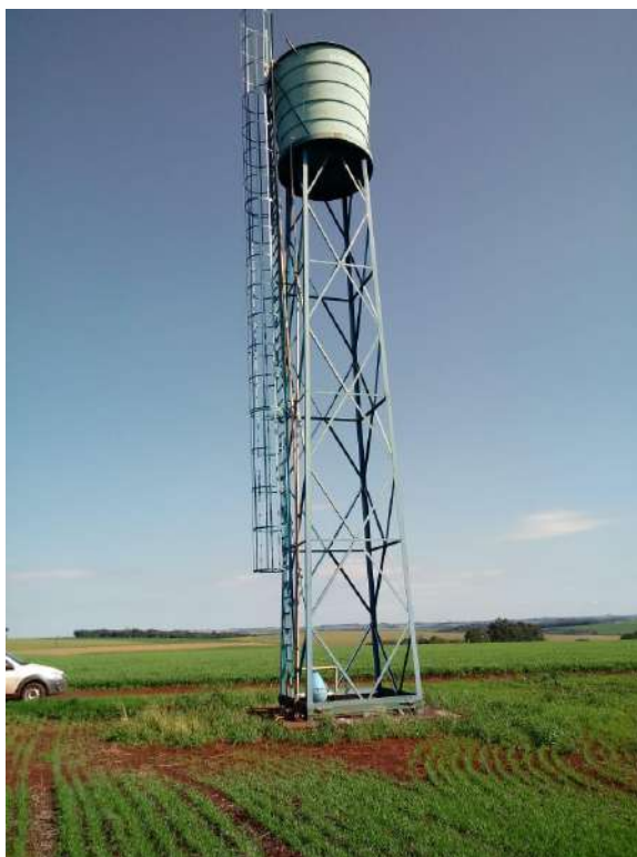
Figura 65 – Reservatório do SAA Linha Quadros II.
