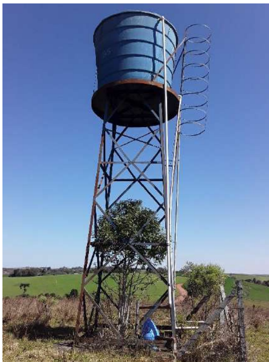
Figura 68 – Reservatório do SAA Segredo-Poço Grande.
