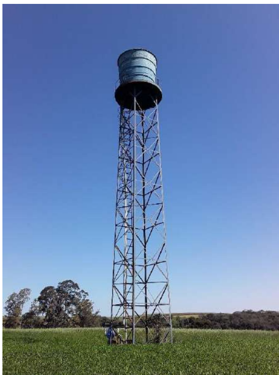
Figura 57 – Reservatório do SAA Segredinho I.
