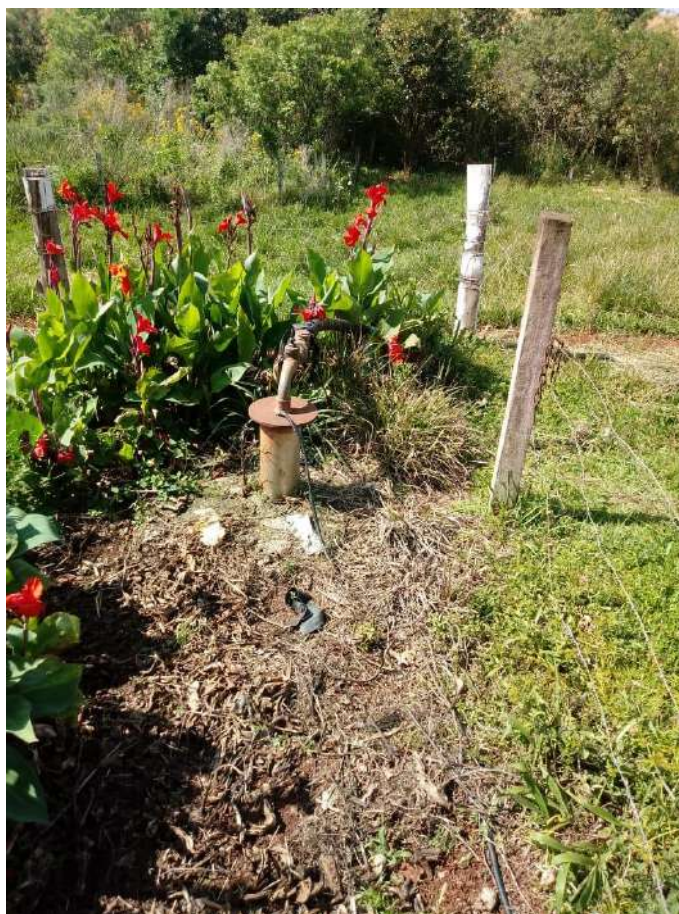
Figura 32 – Vista do poço da Associação de Moradores de Linha Invernada.
