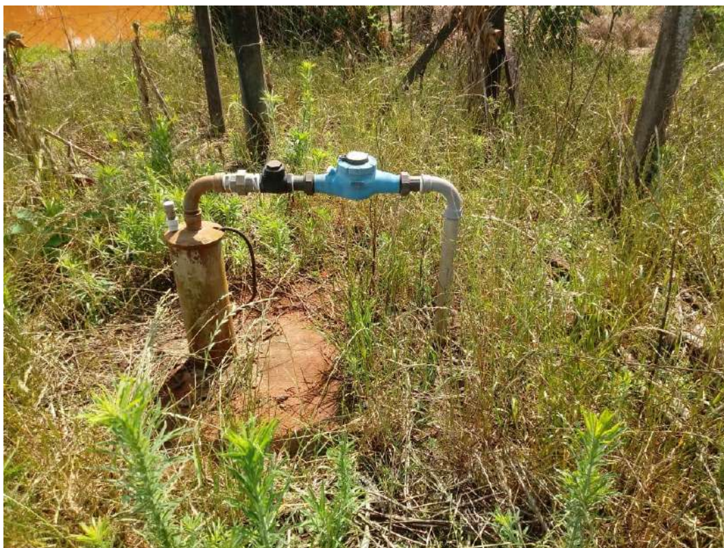
Figura 44 – Vista do poço do SAA Vila Seca.
