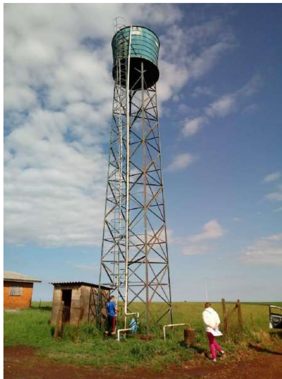
Figura 64 – Reservatório do SAA Linha Quadros I.
