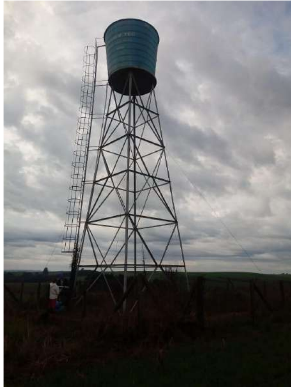
Figura 55 – Reservatório do SAA Segredo-Canhada Funda.
