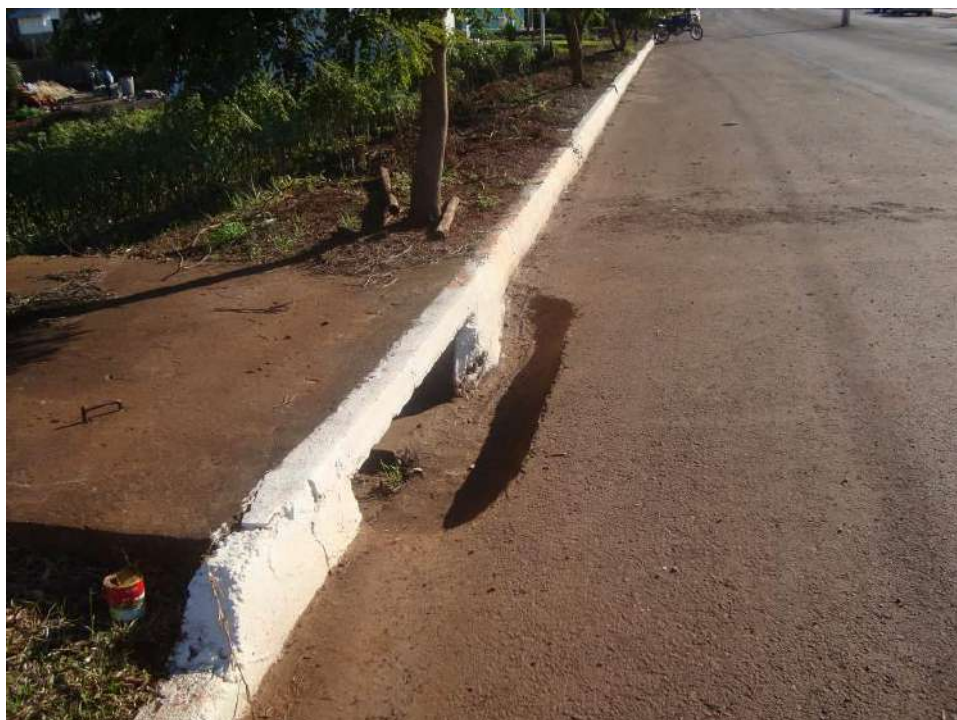
Figura 89 – Bueiro instalado com presenta de um degrau junto a sarjeta.
