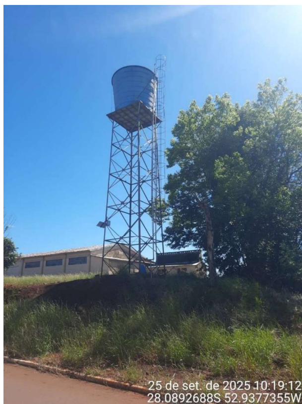
Figura 73 – Reservatório do SAA Vila Seca.
