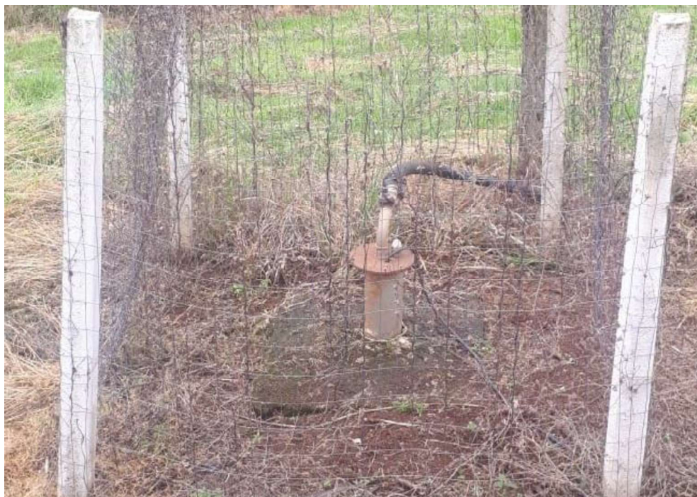
Figura 32 – Vista do poço do SAA Mata Cobra – Propr. de Evandro Damiani
