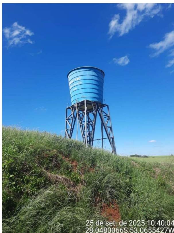
Figura 66 – Reservatório do SAA Linha Barichello. – Gervasio Barrichello
