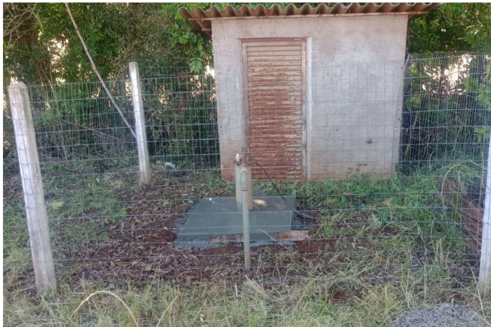
Figura 47 – Vista do poço do SAA Mata Cobra – Propr. de Francisco Maggioni.
