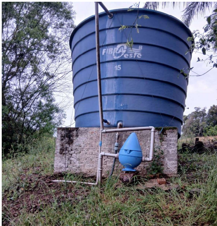
Figura 69 – Reservatório do SAA Linha Guamirim II.
