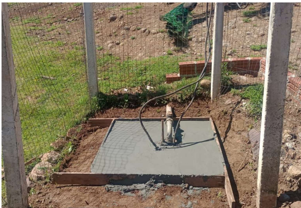
Figura 45 – Vista do poço do SAA Segredo Poço Grande.
