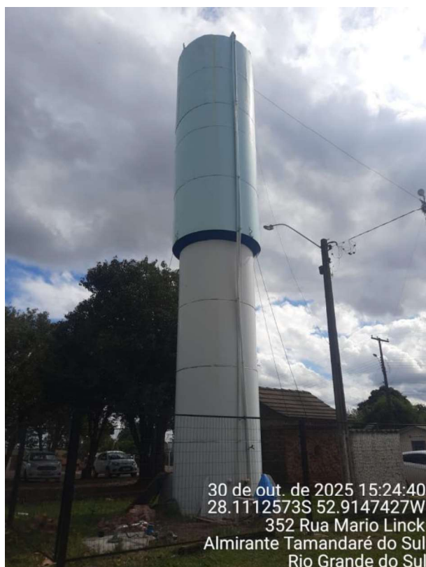
Figura 59 – Reservatório de água pertencente à Associação Comunitária dos Consumidores de Água da Cidade de Almirante Tamandaré do Sul.
