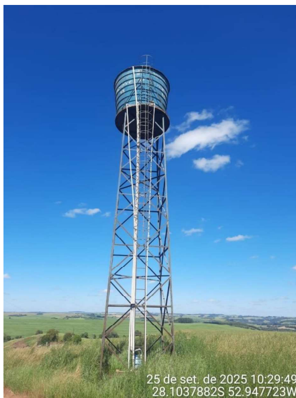
Figura 67 – Reservatório do SAA Linha Barichello. – Pedro Gerevine
