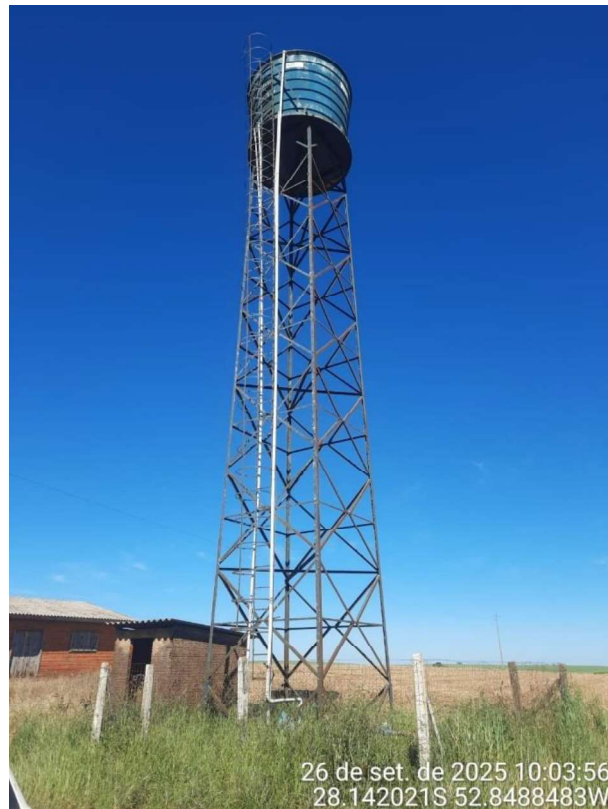
Figura 71 – Reservatório do SAA Linha Quadros I.
